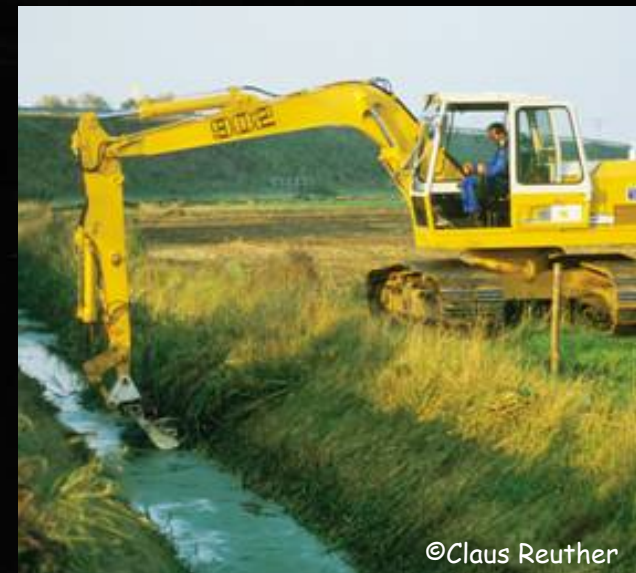
Curage mécanique d'un fossé
