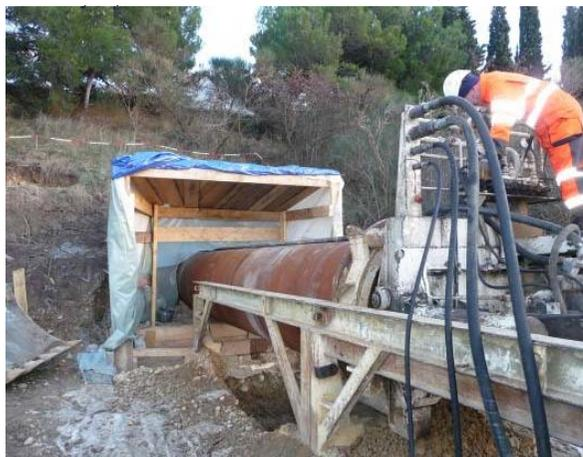
Fonçage d'une buse en Ø1200mm A7
