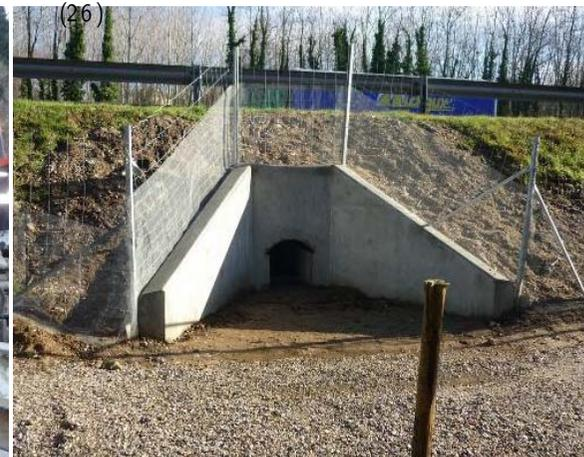
Fonçage de buse Ø800 mm achevé sur A7 (26)
