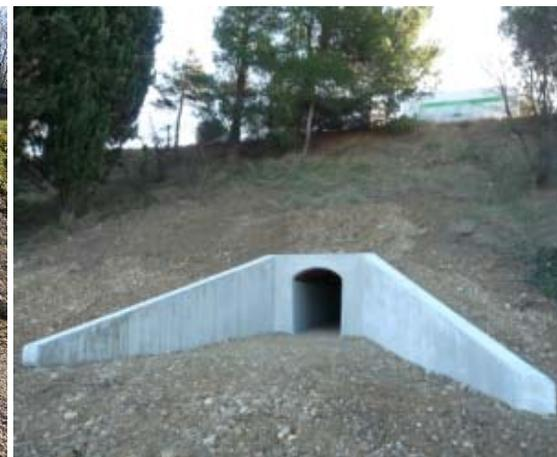
Finition des têtes de la buse Ø1200mm A7
